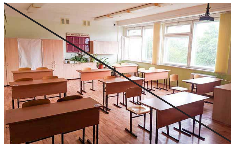
Плохо Линолеум под дерево
